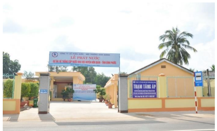
Trạm tăng áp huyện Hớn Quản – tỉnh Bình Phước
