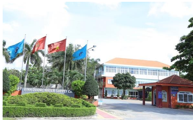
Chi nhánh Cấp nước Dĩ An công suất 300.000 m 3 /ngày
